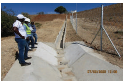
Figura 12: Drenagem do talude de jusante e a rede de vedação no pé de jusante – Barragem Massingir
